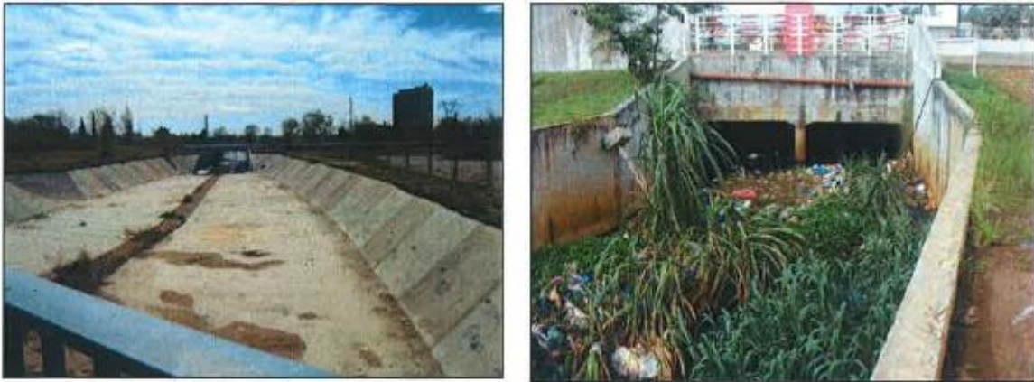
Figure 6 : Sections bétonnées trapézoïdales et rectangulaires
