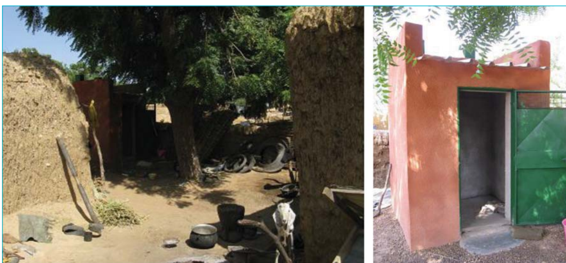
Figure 6 - Toilette subventionnée dans le cadre d'un projet au Burkina Faso : la toilette coûte plus cher que les maisons de la concession. Elle n'est donc pas utilisée comme toilette mais comme grenier... (Source : Eau vive)
