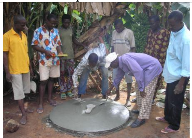
Finition de la dalle par les maçons
