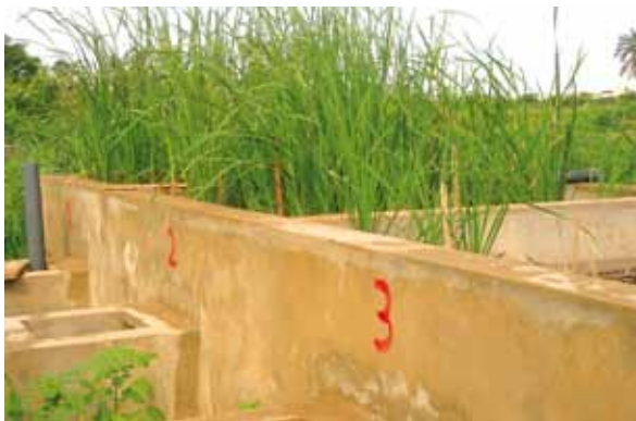
Photo 1 : Vue d'ensemble des lits de séchage
