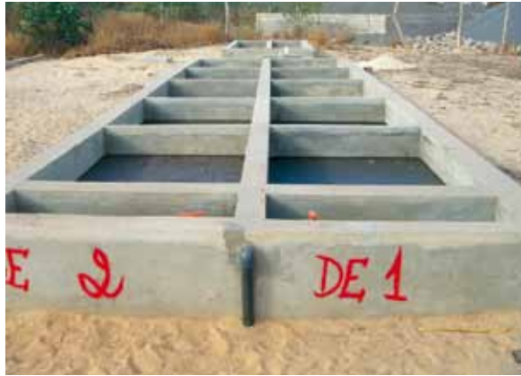
Figure 1: Vue schématique du décanteur épaisseur
