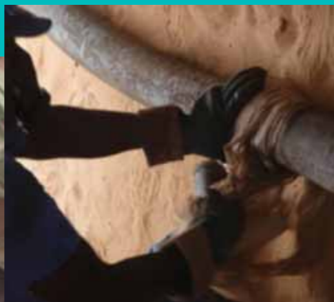
Flexibles raccordés à l'aide de sachets plastiques et de morceaux de chambre à air
