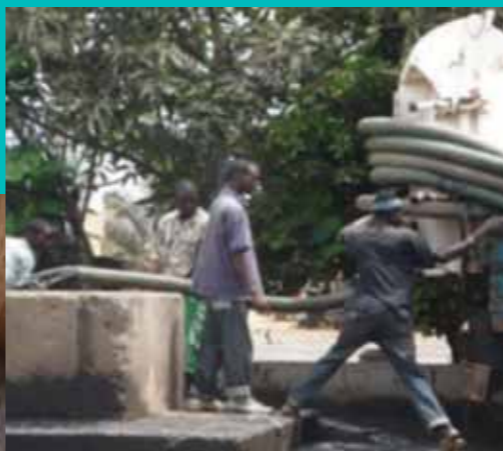
Flexibles raccordés à l'aide de sachets plastiques et de morceaux de chambre à air
