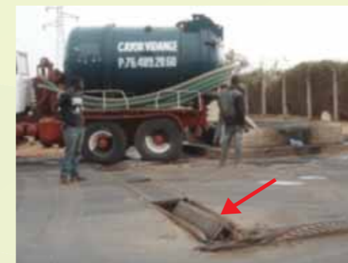
Grille avaloir de récupération de liquides endommagé
