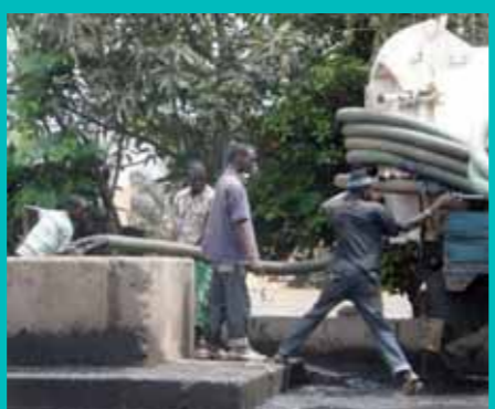
Vidangeurs mécaniques sans EPI
