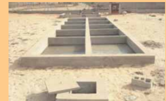
Figure 1: Vue schématique du décanteur épaississeur
