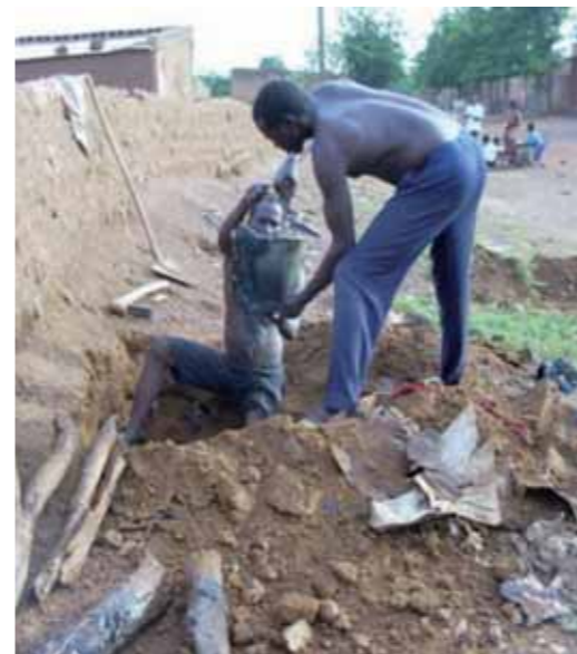
Photo 1 : Opération de vidange manuelle
