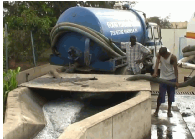
DEPOT DES BOUES DE VIDANGE
