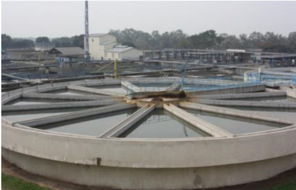
USINE DE TRAITEMENT DE NJILI
