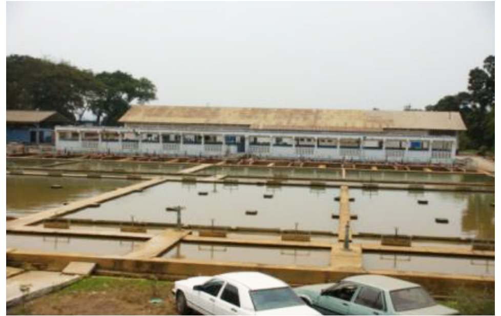
USINE DE TRAITEMENT DE LUKUNGA
