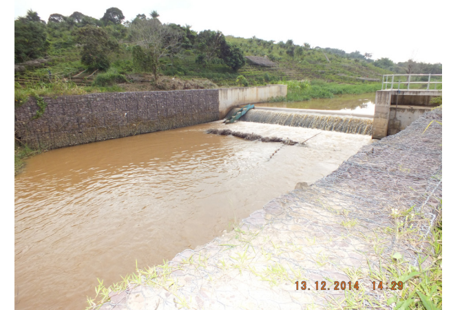
VUE DE L'USINE DE CAPTAGE DE LUKAYA
