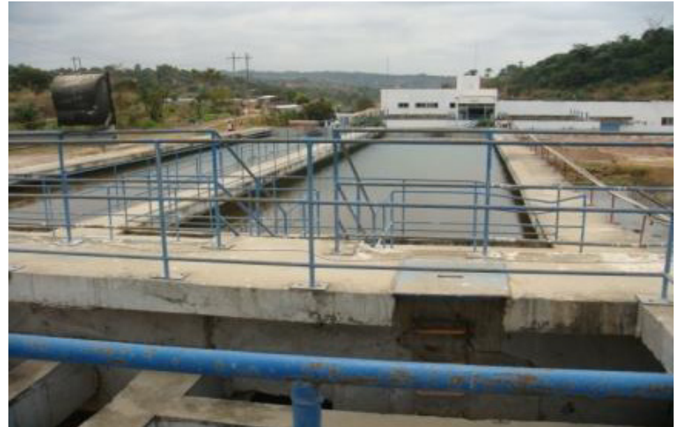
USINE DE TRAITEMENT DE LUKAYA
