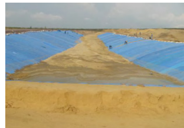
VUE D'UN CASIER APRÈS TERRASSEMENT
