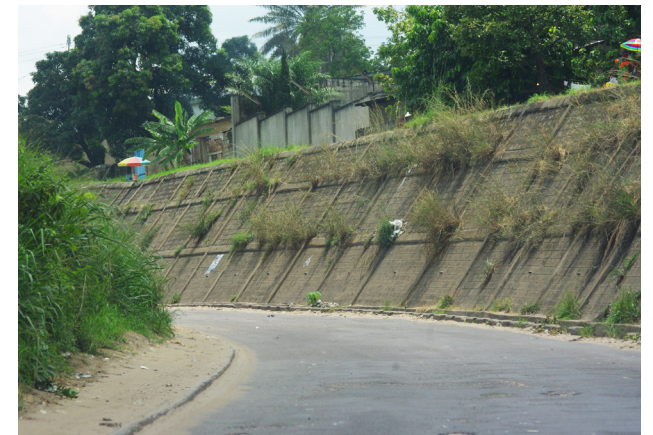
MUR DE SOUTENEMENT, MESURE DE PREVENTION
