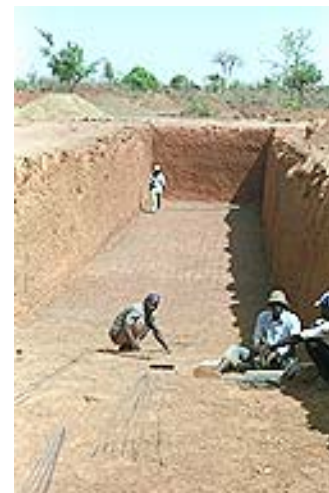
Photo 4 : Construction d'un bassin de décantation à la STBV de Santinabougou.
