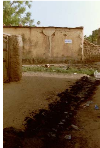
Photo 2 : Rue de Magnambougou Village (zone défavorisée) avec l'improvisation d'un caniveau d'évacuation des eaux usées.
