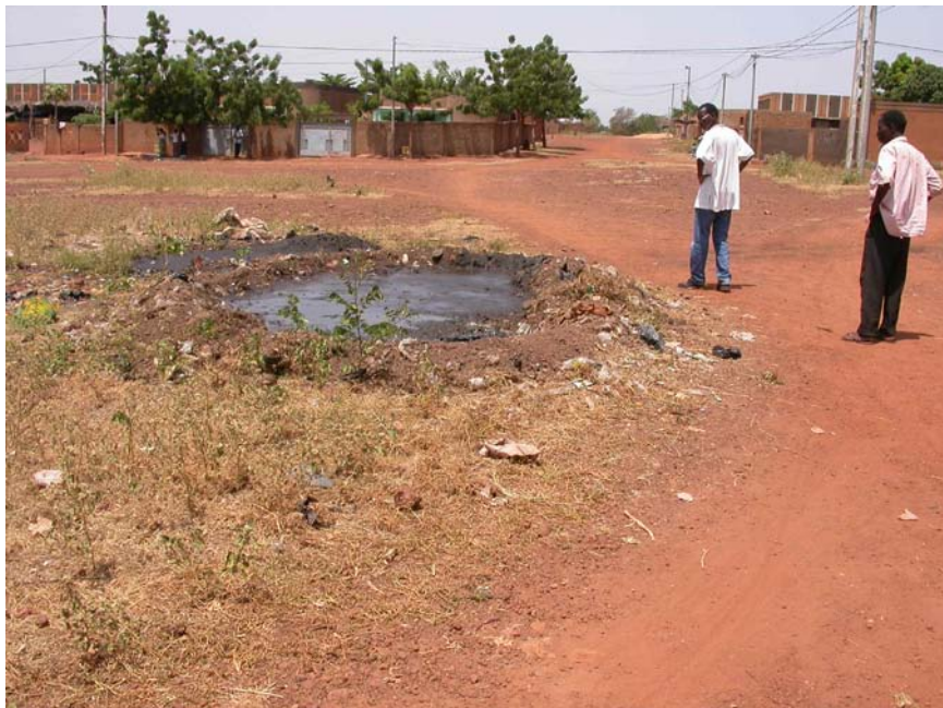
Figure 2.2 : Déversement de boues de vidange dans une rue de la ville de Ouahigouya
