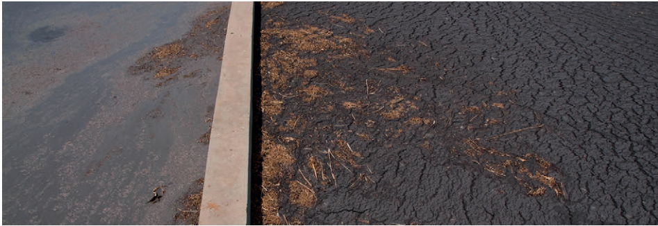
Figure 7.2 : Boues de vidange fraîchement déversées et partiellement déshydratées sur les lits de séchage non-plantés de la station de traitement des boues de vidange de Niayes, Dakar, Sénégal (photo : Linda Strande).
