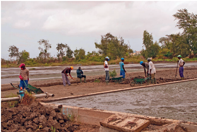
Figure 12.2 : Curage des boues de lits de séchage pour réutilisation en agriculture, Dakar, Sénégal (photo : Linda Strande).
