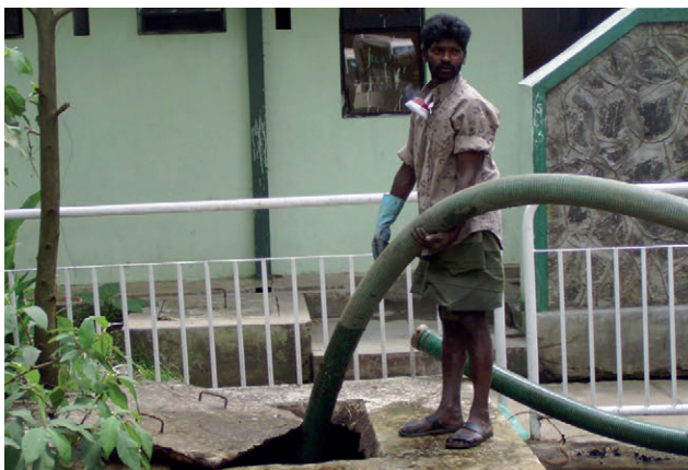
Figure 4.1 : Vidange d'une fosse septique à l'aide d'un équipement d'aspiration sous vide. La sécurité des opérations serait meilleure avec des équipements de protection mieux adaptés (photo : David M. Robbins).
