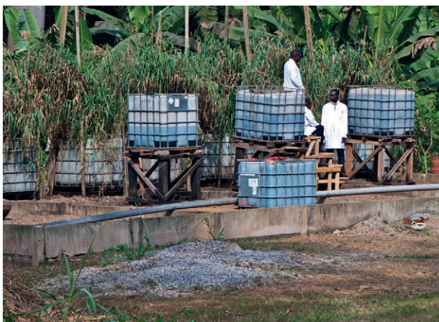
Figure 8.1 : Pilote de lits de séchage plantés pour le traitement des boues de vidange de l'université de Yaoundé I (photo : Linda Strande).
