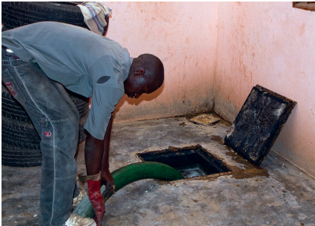
Figure 4.2 : Exemple d'une opération de vidange à Dakar, Sénégal. La fosse est située dans une cour intérieure dont l'accès requiert la concertation entre les résidents (photo : Linda Strande).
