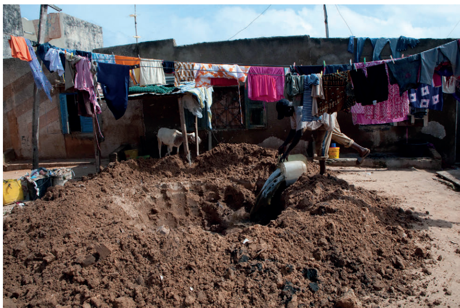
Figure 14.9 : Vidange manuelle de boues avec enfouissement dans la cour (photo : Linda Strande).
