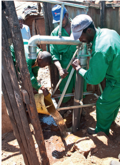
Figure 2.2 : Ajout d'eau pour faciliter le pompage avec une pompe « Gulper » des boues d'une latrine à fosse simple dans un quartier informel de Kibera, Nairobi, Kenya (photo : Linda Strande).
