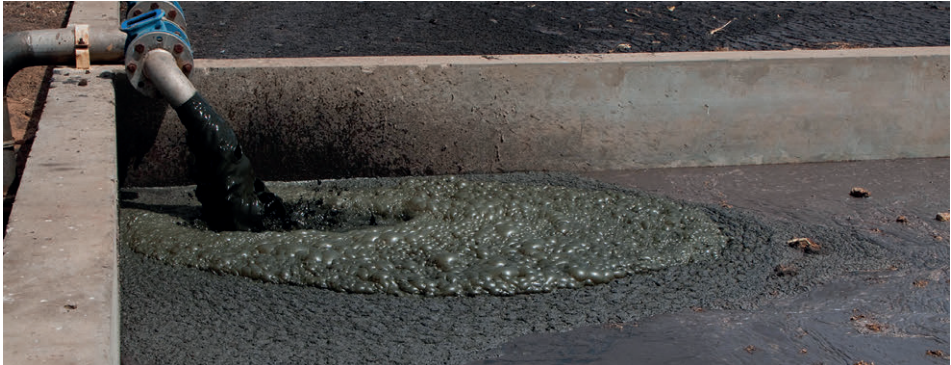
Figure 7.4 : Application de boues dans les lits de la station de traitement de Niayes, Dakar, Sénégal (photo : Linda Strande).
