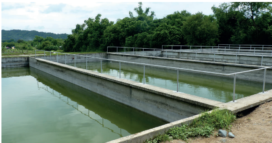
Figure 11.8 : Mise en exploitation d'un système de lagunage pour le traitement de boues de vidange à San Fernando, Philippines. Dans ce cas, les bassins de lagunage ont été inoculés avec des boues d'une station de traitement des eaux usées située à proximité (photo : David M. Robbins).
