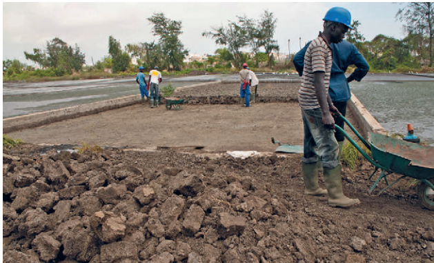
Figure 7.5 : Curage des boues de lits non-plantés à la station de traitement de Cambérène, Dakar, Sénégal (photo : Linda Strande).
