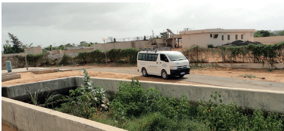
Figure 6.5 : Exemple d'exploitation-maintenance inadaptée d'un bassin de décantation et d'épaississement en Afrique de l'Ouest. La couche d'écume qui n'a pas été extraite depuis longtemps sert de support au développement de végétaux. Les volumes de boues et d'écume accumulés dans l'ouvrage ne permettent plus d'atteindre la performance escomptée et nécessitent des moyens plus importants pour le nettoyage (photo : Sandec).
