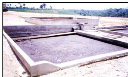
Photo 2: Sludge drying beds (Kumasi)
