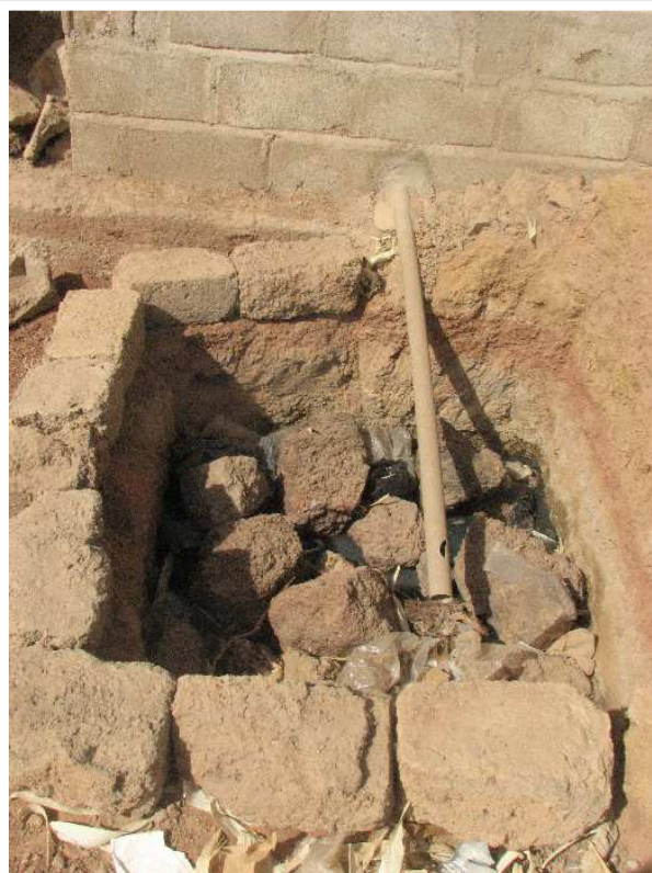
Photo 19 : Construction d'un puit perdu à côté de la cour pour mieux éliminer les eaux ménagères.
