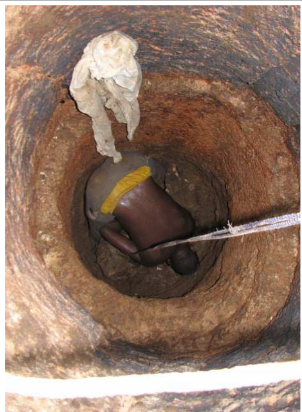
Photo 37 : La vidange manuelle, effectuée avec une pelle, une pioche, un saut et une corde.
