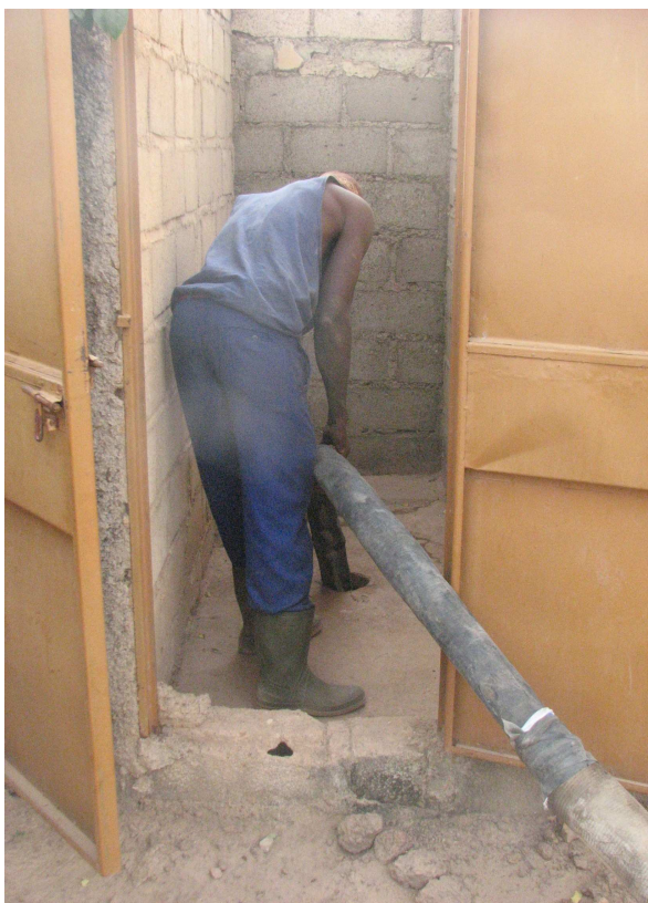
Photo 36 : La vidange mécanique, effectuée avec les tuyaux d'aspiration et les pompes hydrauliques du camion aspiroz.
