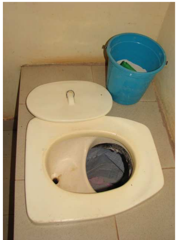
Photo 31 : La version toilette ECOSAN de position assis (modèle CREPA).
