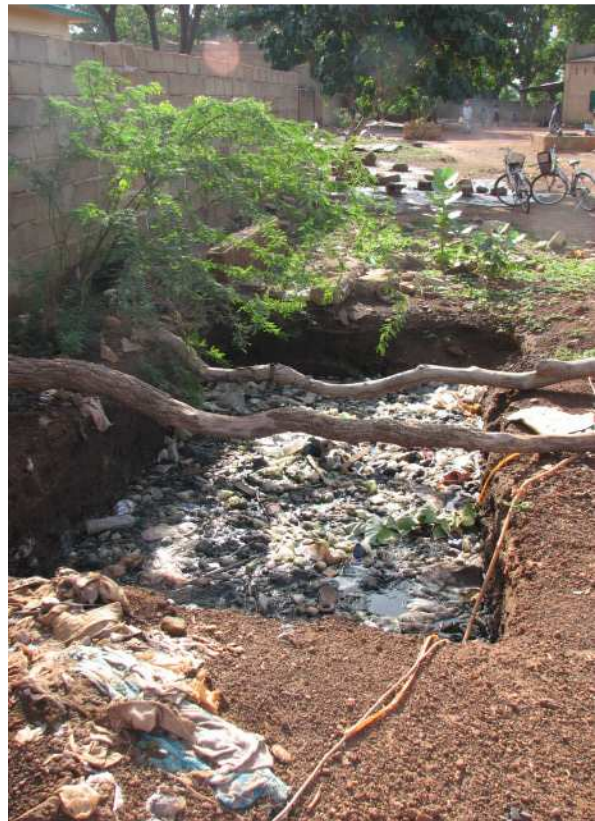
Photo 45 : Site de stockage intermédiaire de la grande mosquée (pour raisons similaires comme au CHR). Il était prévu de mettre encore une dalle, mais après l'argent ne suffisait pas.
