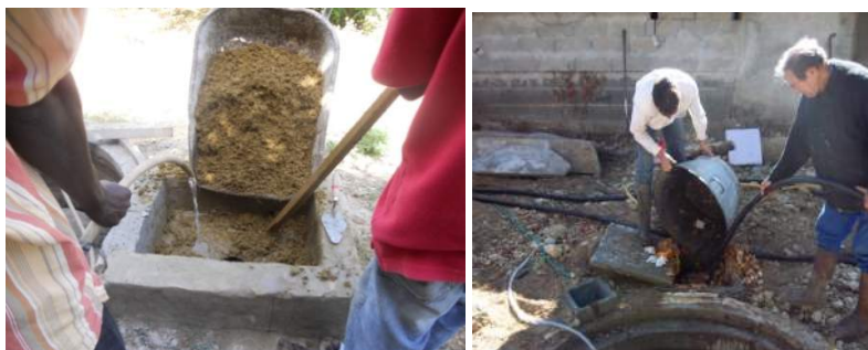
Exemples de remplissage avec contenu de panse et déchets de cantine
