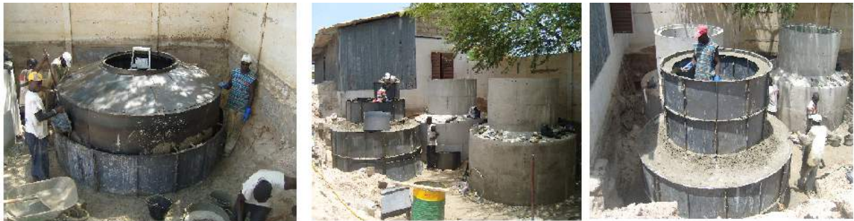
Construction des digesteurs
