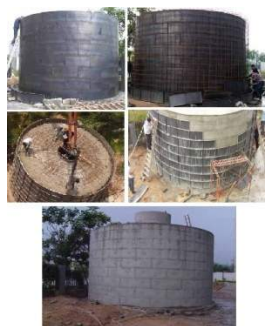
Construction d'un digesteur de 100 m3
