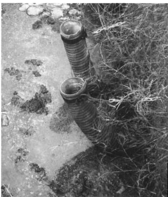
Fig. 54: Tuyaux flexibles pour l'évacuation des boues. Celles-ci sont évacuées par pression hydraulique quand on abaisse le tuyau [photo-.Sasse]
