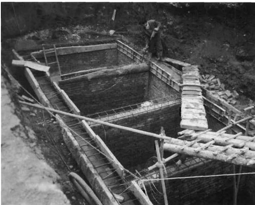
Fig. 3: Filtre anaérobie de type DEWATS en construction. Conception et encadrement assurés par CEEIC [photo: Sasse]
