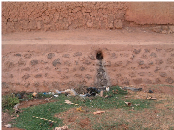
Rejet d'eaux usées dans le réseau de drainage des eaux pluviales
