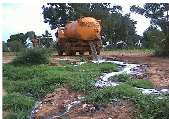
Une séance de dépotage de boues en périphérie de la ville
