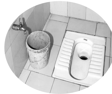
Pour flush toilet
