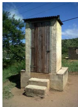
UDT (Front View)
