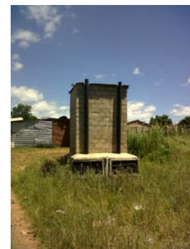
UDT (Rear view)
