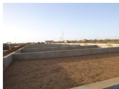
Filtres en construction (Photo : CD94)
