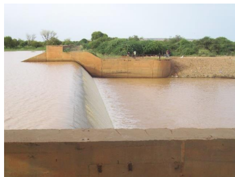
Barrage de Téra (Photo : Yayé Moussa)
