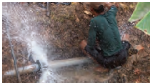
Repairing a distribution leak (d)
