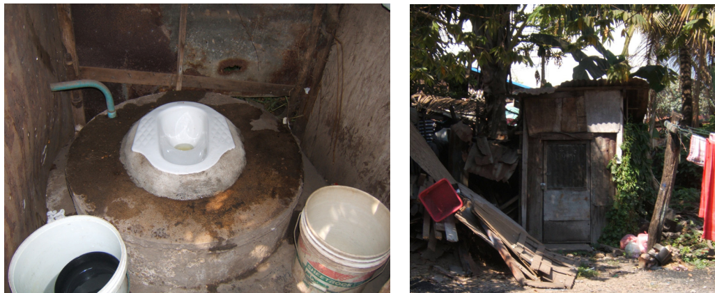
Photo 2: Pour flush squatting latrines with soak pits in Hatsady Tai
